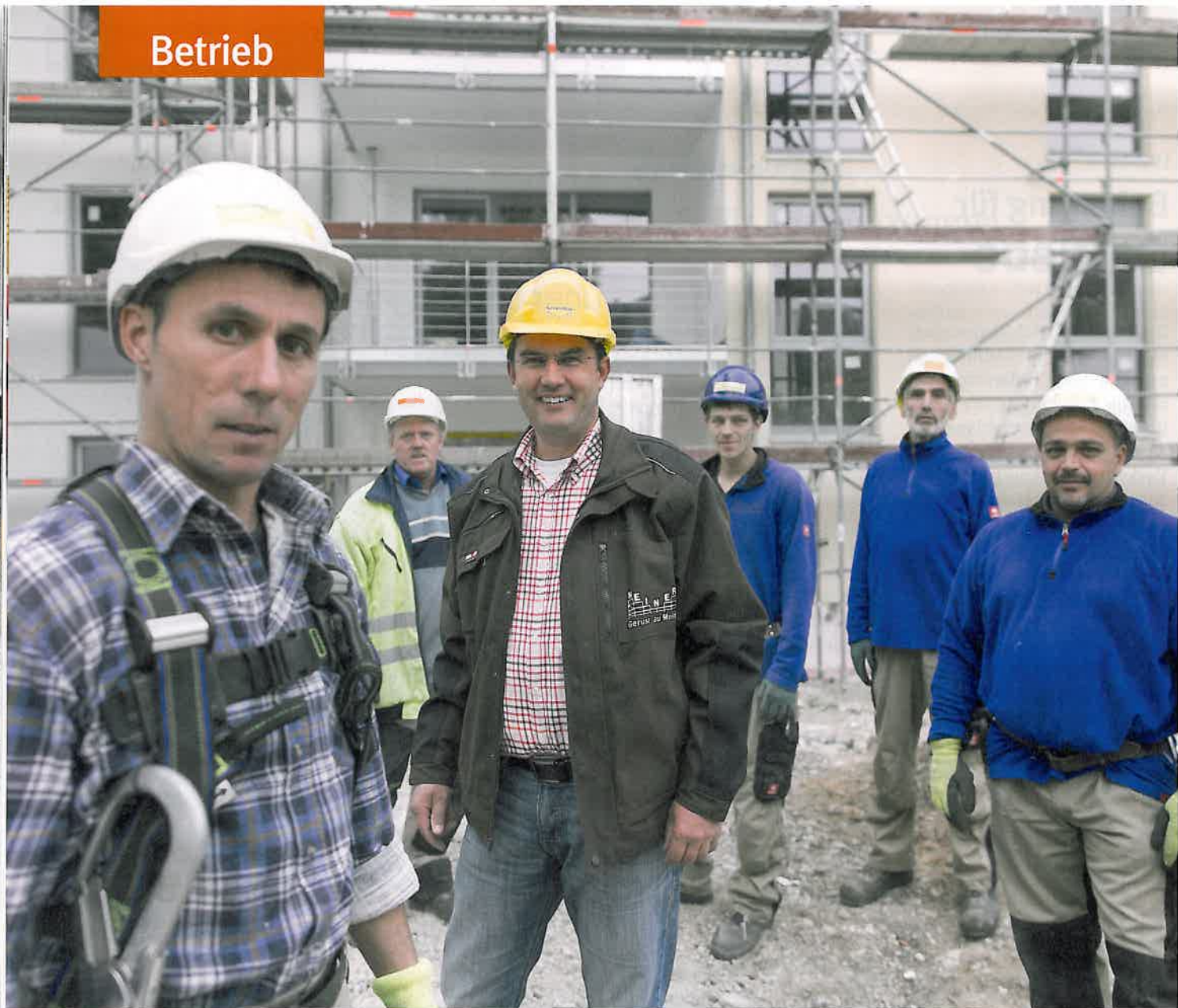
Gerüstbauer Heiko Meiners (mit gelbem Helm) hat den Arbeitsschutz mit System, aber praxisnah geregelt.
